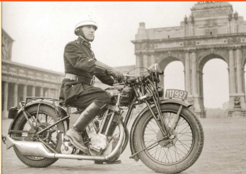
V roce 1931 proběhla modernizace pětistovek Sarolóa, která s trochou nadsázky vydržela až do konce činnosti firmy v roce 1960. Šikmý válec, zásoba oleje v přední části karteru, masivní vidlice atd. Nadějná budoucí motocyklistka krátce po válce cloumá v Praze řazením modelu 31S (1931) a na druhé fotografii strážce zákona hrdě pózuje v bruselském Parc du Cinquantenaire na o rok novějším modelu 32S
